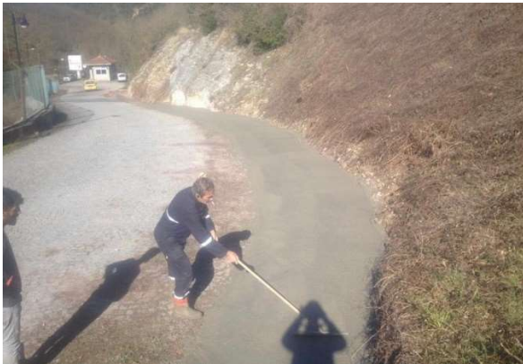
Fotoğraf-1: Yol genişletme çalışması
